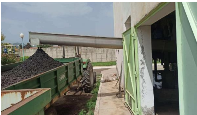
Figure II.11 : Transport de boue déshydratée [15]
