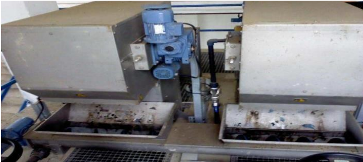
Figure II.4 : Dégrilleurs [15]
