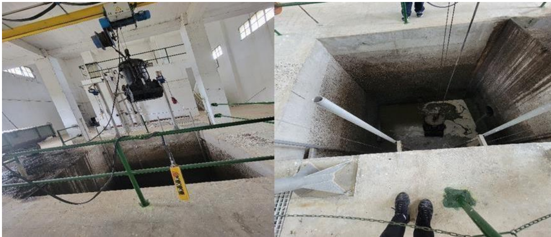
Figure II.3 : puits et grille grossières [15]
