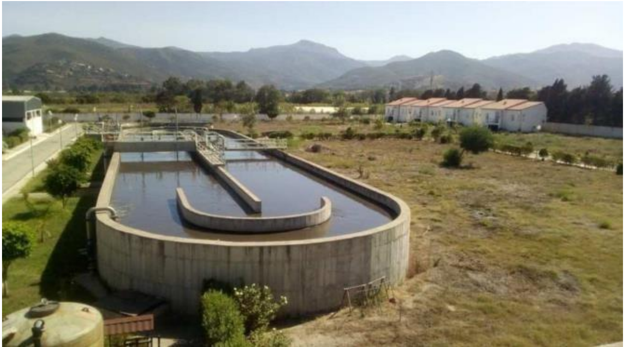
Figure II.6 : Réacteur biologique (système Carrousel) [15]
