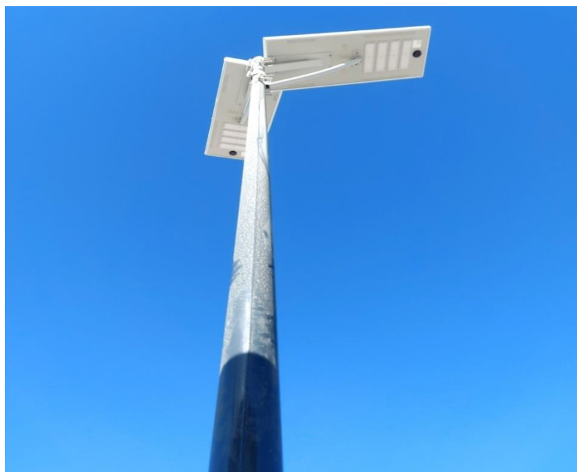
Figure III.20 : Montage d'un panneau double crosse
