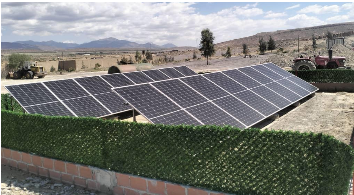
Figure III.14 : Installations des panneaux photovoltaïques au sol
