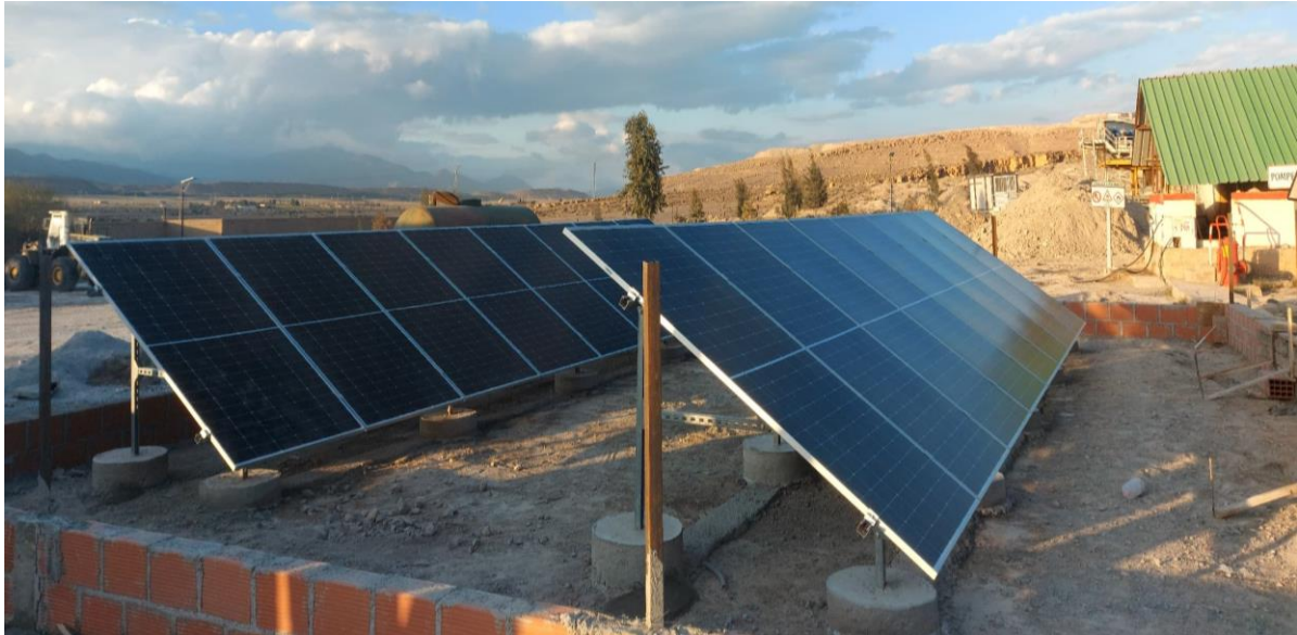
Figure III.6 : Installation des panneaux solaires sur la structure
