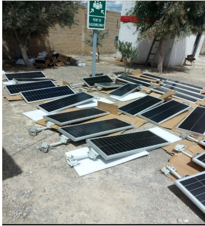
Figure III.16 : Chargements des lampadaires par soleil sur terre
