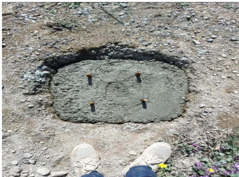
Figure III.19 : Préparations du socle
