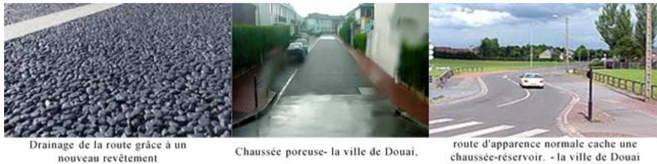
Figure 2-8 : Les chaussées à structure réservoir et poreuse
