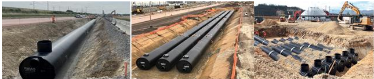
Figure 2-9 : Les réseaux surdimensionnés
