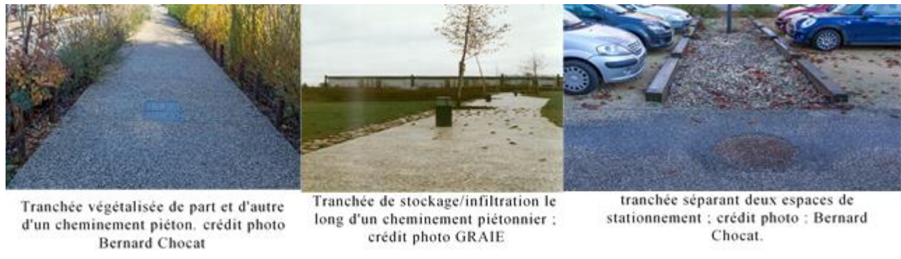
Figure 2-5 : Les tranchées drainantes
