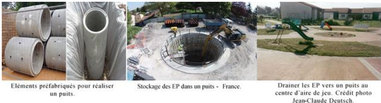
Figure 2-4 : Les puits de stockage-infiltration des eaux pluviales
