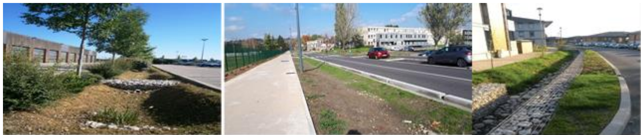
Noue cloisonnée par des gabions. Crédit photo GRAIE
