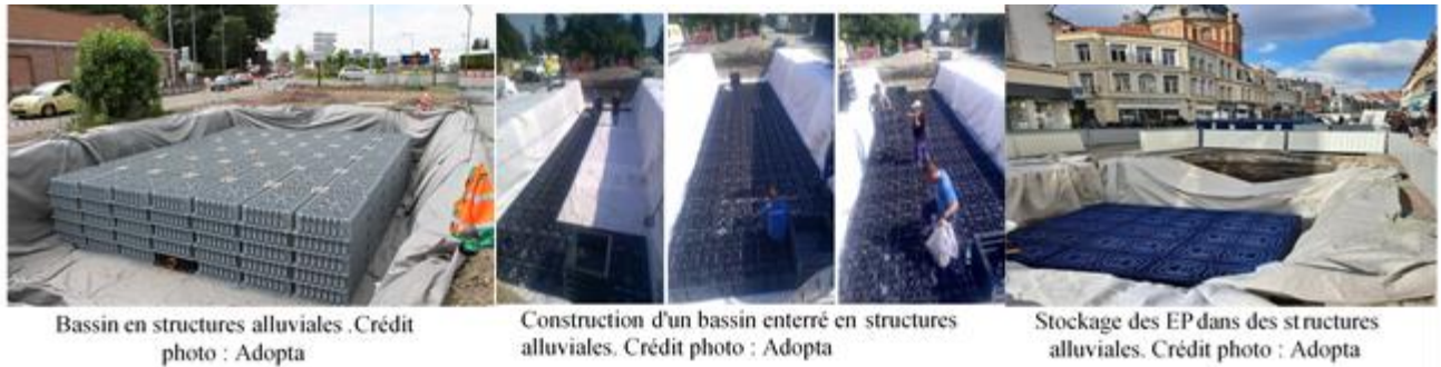
Figure 2-6 : Les structures réservoirs
