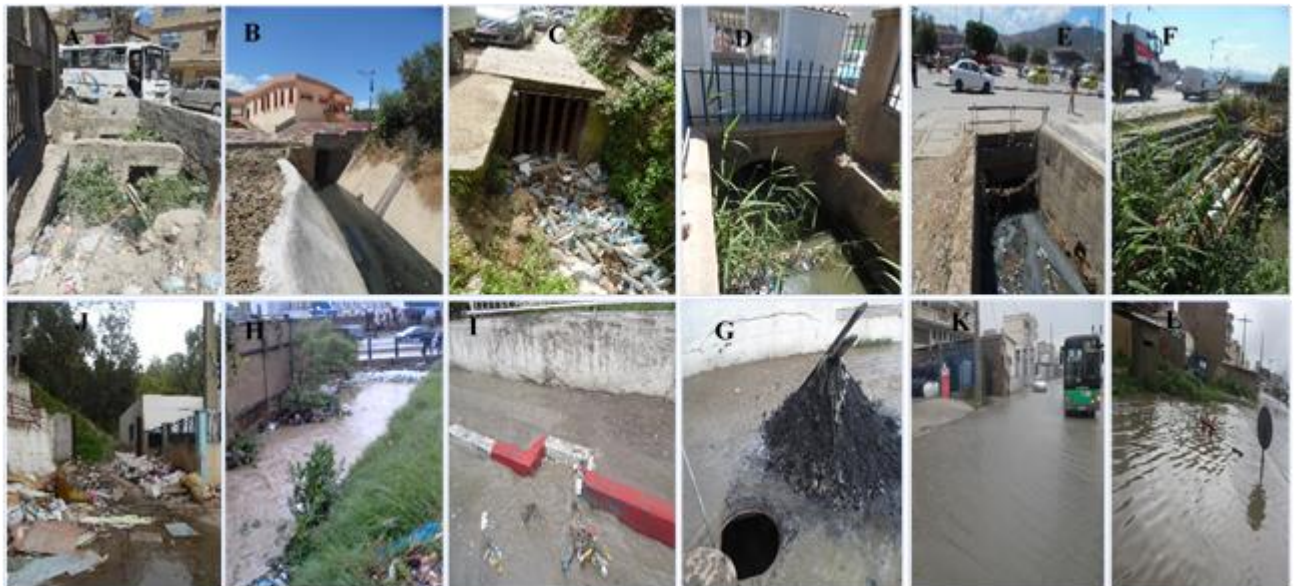
Figure 2-16 : Insuffisance de capacité du réseau de Bejaia. Obstacles d'écoulement et réduction de section ((A), (B), , (D), (E), (F), (E), (G), (H)) ; Manque d'entretien périodique (I) ; Dépôt dans les regards (J) ; Eaux pluviales non drainer ((K), (I))
