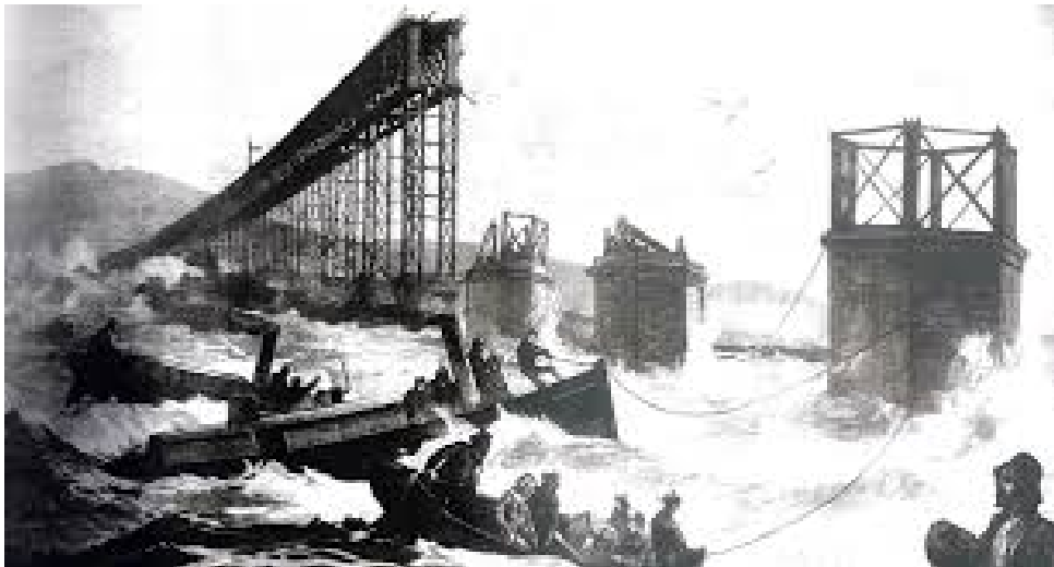
Figure 1.9 – Catastrophe du pont Tay bridge en Écosse, le 28 décembre 1879 [118]
