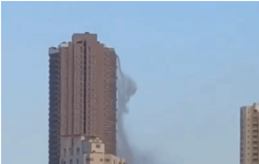
Figure 1.3 – Ballotement dans une piscine sur le toit d'un gratte-ciel lors d'un séisme [29]
