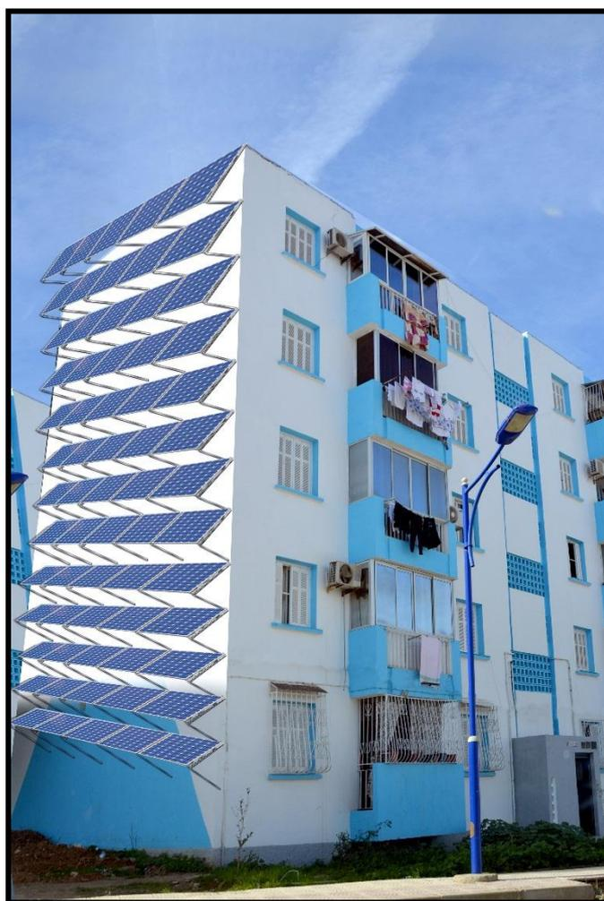
Figure 42 : l'intégration des panneaux photovoltaïques sur la façade sud, scénario 1, (auteur).
