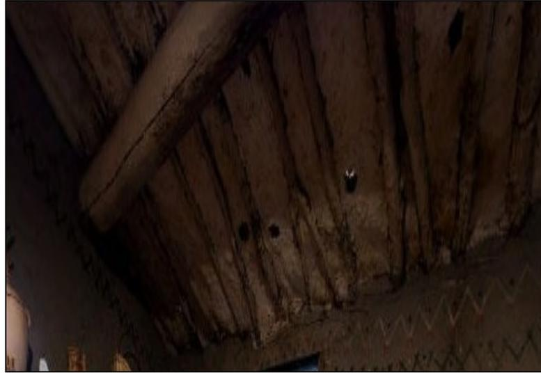
**Figure 81:** Plancher avec des trous d'aération (après la réhabilitation), Djebba
