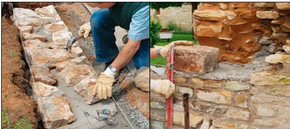
**Figure 73:** Technique de reconstruction des murs en pierre.
