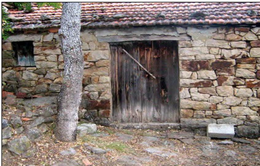
**Figure 91:** Exemple d'une porte traditionnelle d'une maison kabyle à deux volets.
