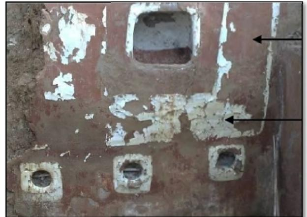
**Figure 28:** Enduit appliqués sur les parois intérieures des maisons, village de Maatkas. Source: ALILI. S. Op. Cite. P.68
