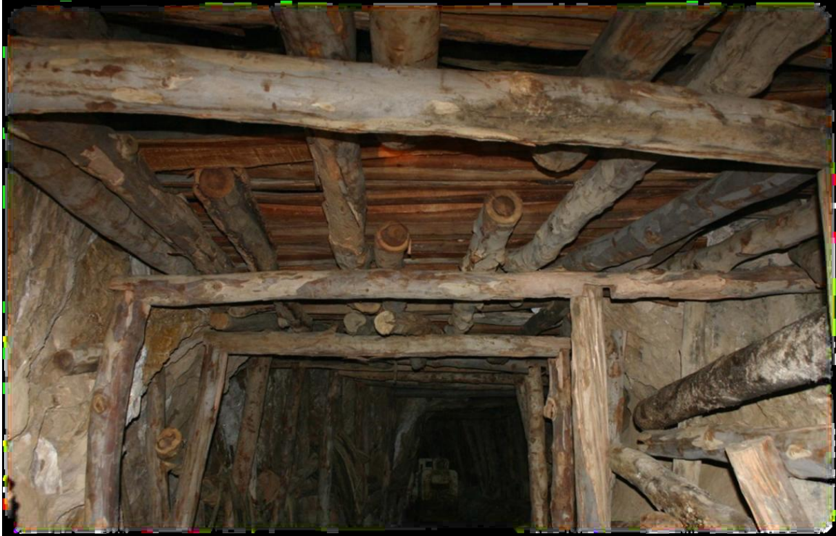
Figure III.05 : Cadre en bois de soutènement appliqué dans la mine d'Ain Mimoun.
