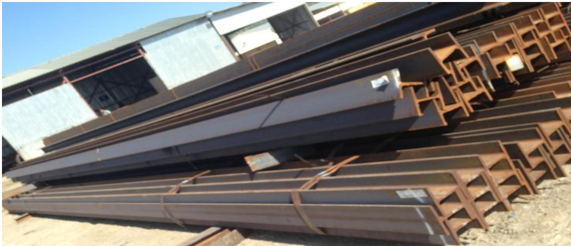
Figure II.18 : Barres métalliques pour les cintres (HEB 200) utilisés dans le tunnel d'Ait Yahia Moussa (Avril-2017).
