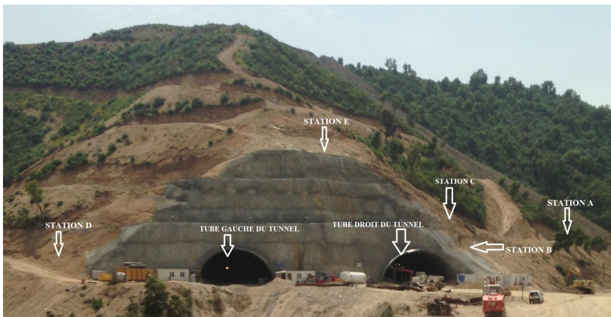
Figure IV.11 : Localisation des différentes stations d'investigation (27/04/2017)
