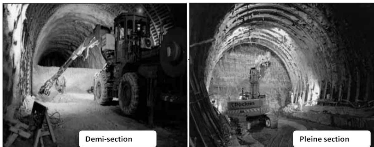
Figure II.13 : Images d'excavations par pleine et demi section [40].
