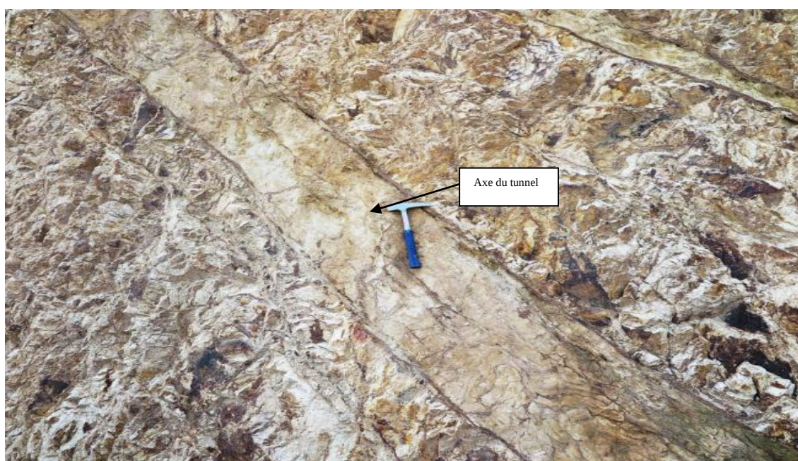
Figure IV.15: Dyke aplitique entrecoupant les métagranites dans le tunnel [53]
