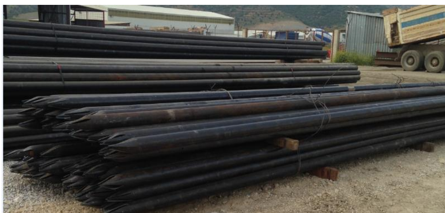
Figure II.16 : Photo de voûtes parapluies utilisées dans le tunnel situé entre Bouira et Draa-El-Mizan (Avril-2017)
