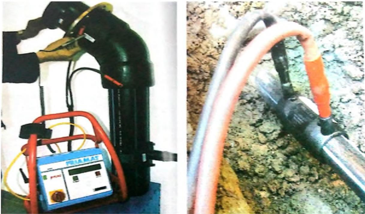
*Figure (III-2) : Moyens de raccords électro soudables*
