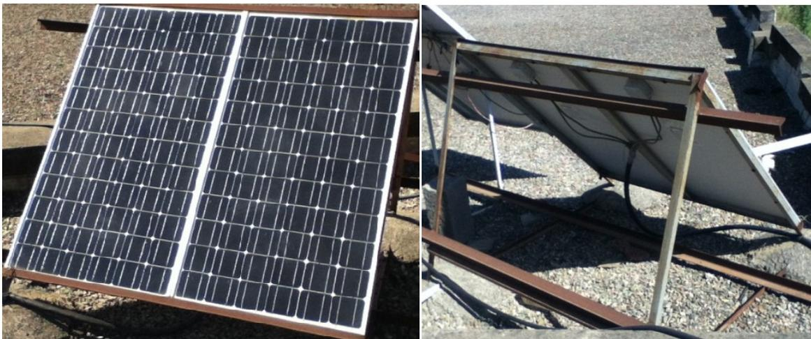
**Figure III.3 :** Générateur photovoltaïque avec support.
