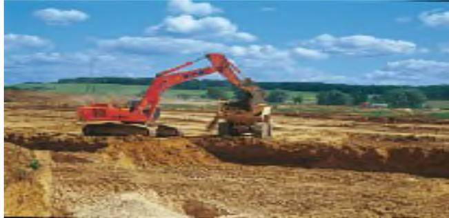
**Figure 2 :** Décapage (ou découverte).
