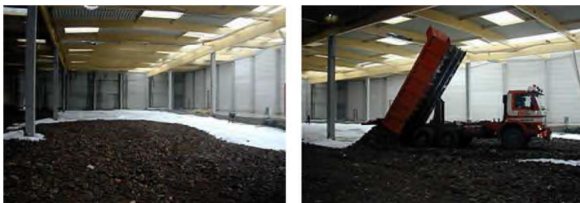
Figure 32 : Couche de fondation d'un hangar.
