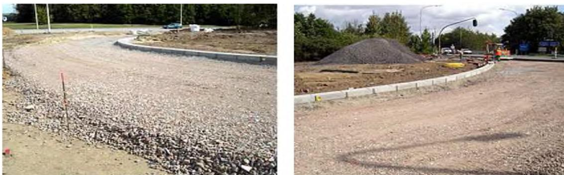
Figure 30 : Sous fondation de chaussées.
