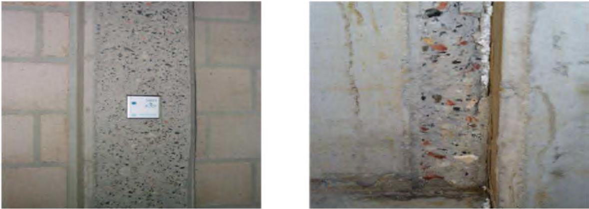
Figure 33 : Voile de béton recyclé.
