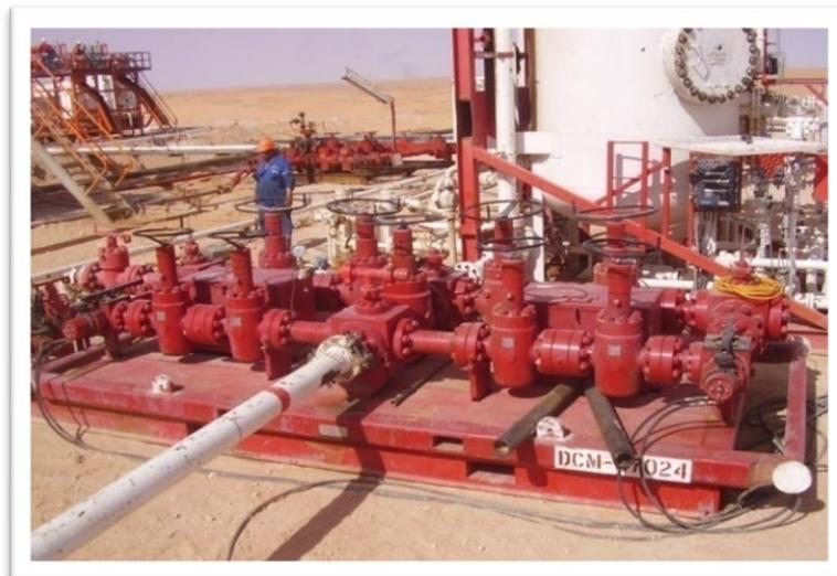
**Figure III.9:** Manifold de l'Underbalance.
