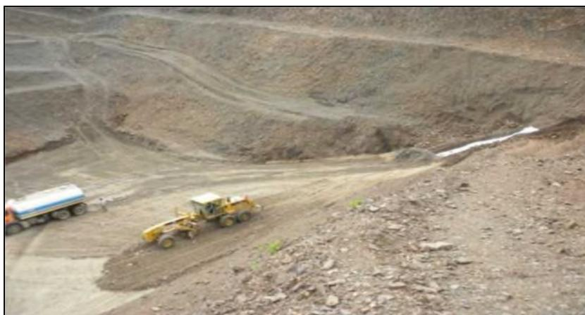
**Figure II. 16:**Travaux de remblai de grande hauteur [15]
