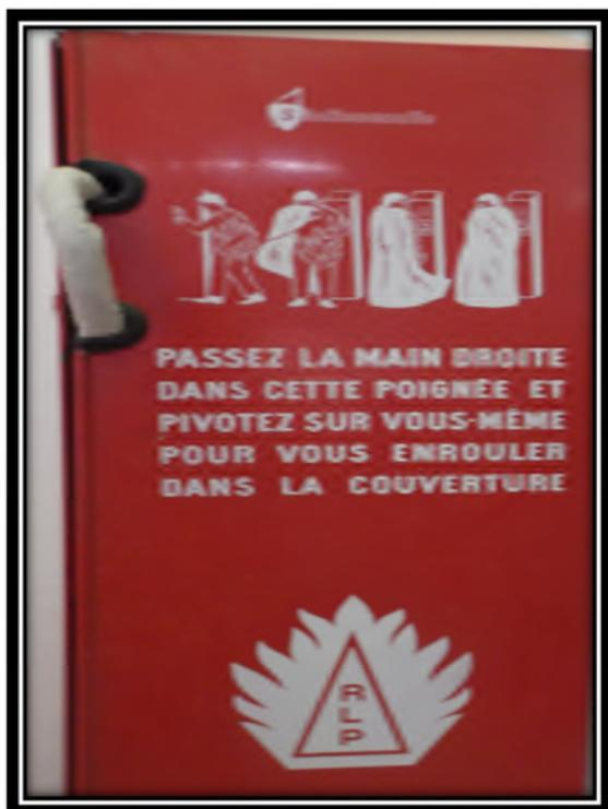
Figure IV.5 : Couverture ignifugé. [126]
