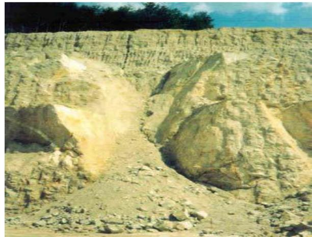
**Figure I.10 : Exemples de rupture de dièdres.[3]**
