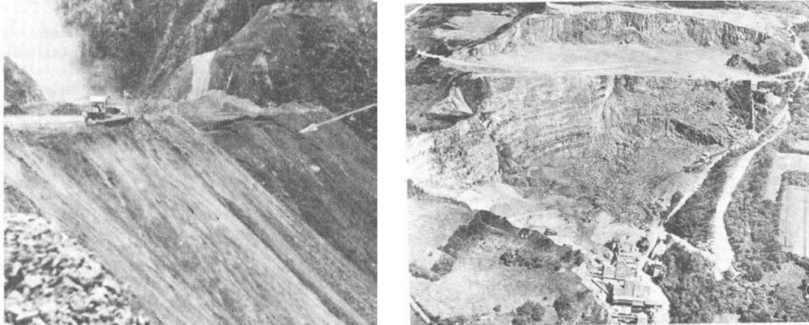
Figure I.7 : Exemples de rupture circulaire.[3]
