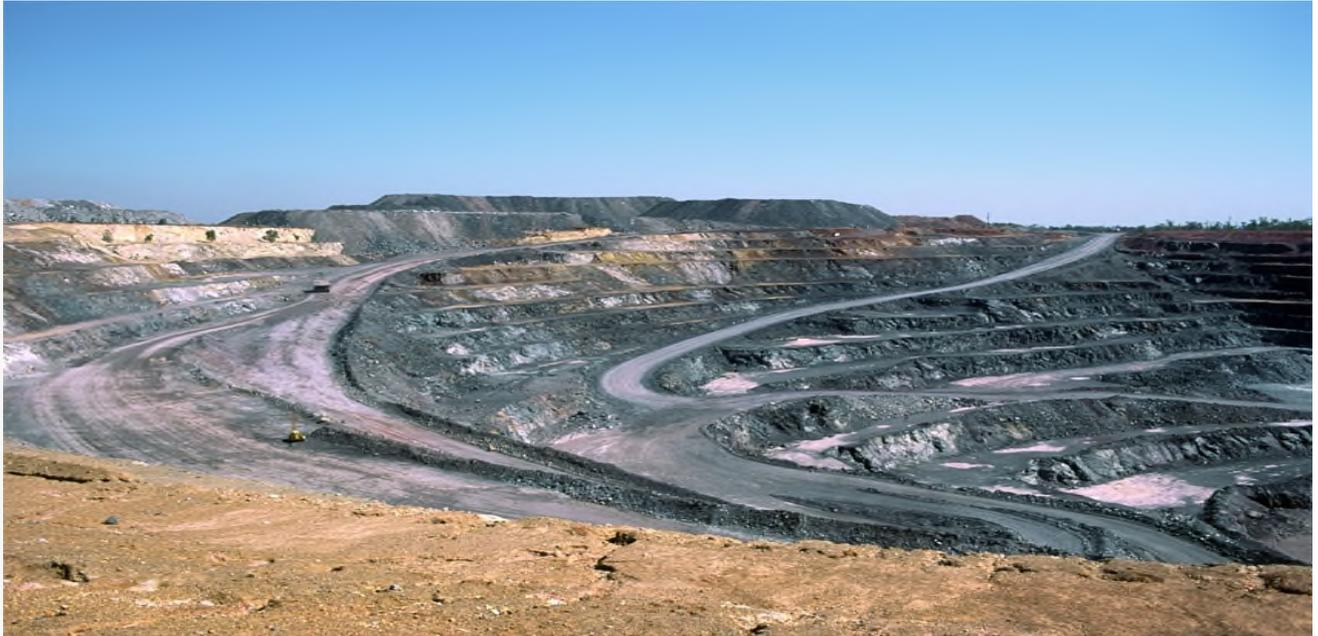
**Figure III.1:** Carrière on distingue les fronts de taille séparés par les banquettes et une piste d'accès. [12]
