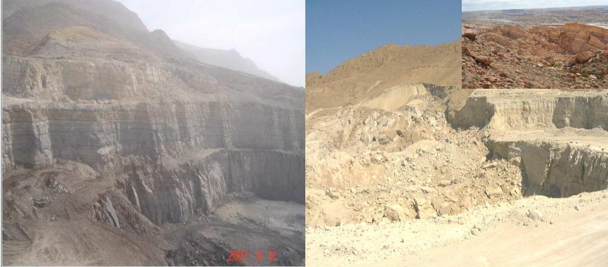
**Figure V.1.** Photos montrant la carrière de Kef Essnoun avant et après glissement.
