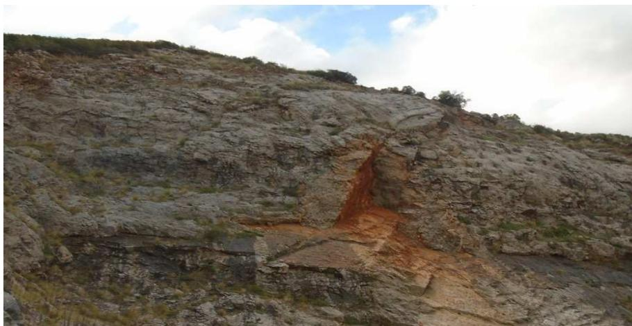
**Figure III.14.** Glissement en dièdre dans un massif (Aokas –Bejaia-, 2015).
