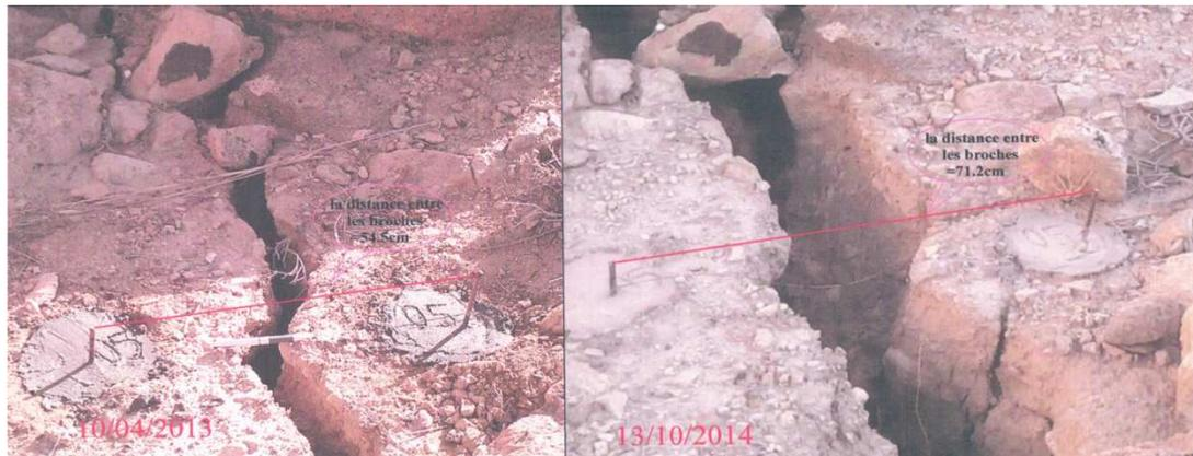
**Figure V.3.** Evolution des fissures.
