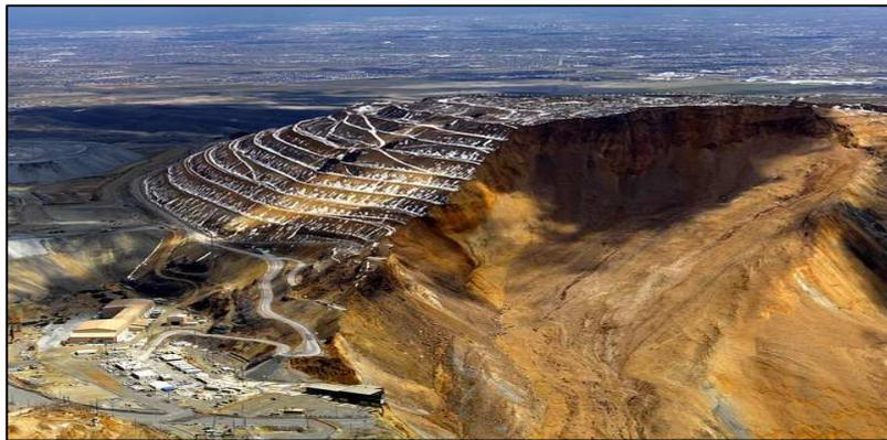
**Figure III.8.** Cas du glissement circulaire de la mine d'Utah en 2013 (U.S.A).
