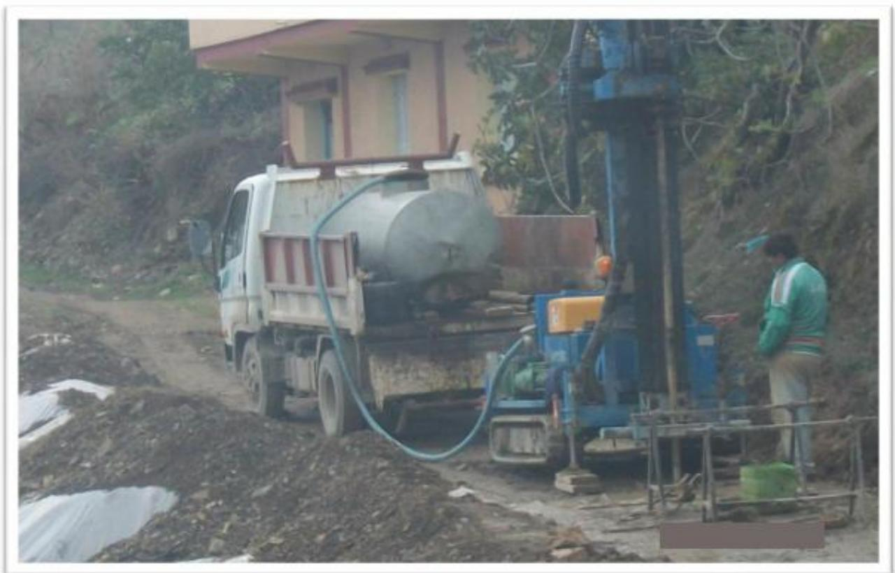
**Figure 36:** Implantation d'un point de sondage carotté au côté amont du glissement.
