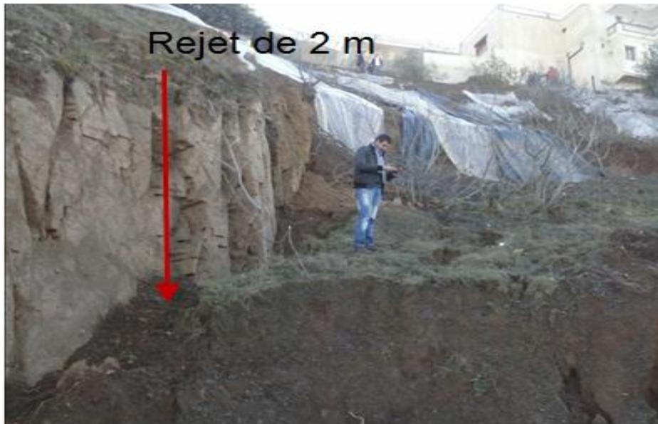
**Figure 35:** Rejet d'une rupture de talus amont du glissement de Bouhamza.
