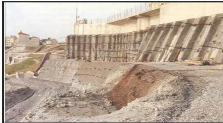
**Figure 22:** Schéma de confortation par tirants d'ancrages [15].
