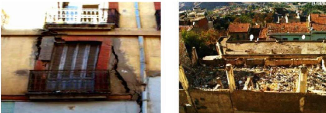
**Figure 12:** Fissures causées par le Glissement de terrain à Belouizdad. 2002 [15].
