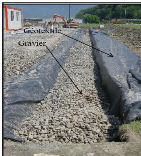
Figure18: Coupe type d'une tranchée drainante [1]
