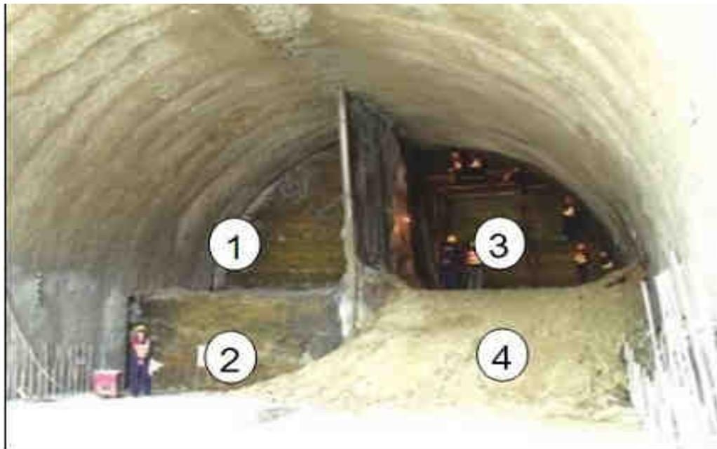
**Figure-II-9-** Excavation mécanique par la méthode CRD
