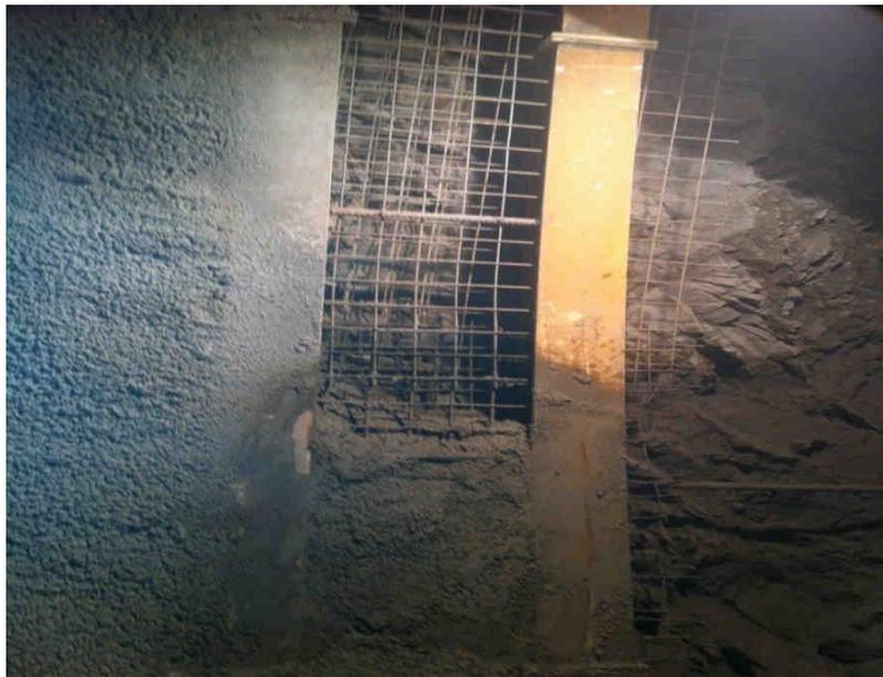
**Figure-II-10-** Exemple d'un Soutènement composé de cintres et béton projeté avec treillis soudés.
