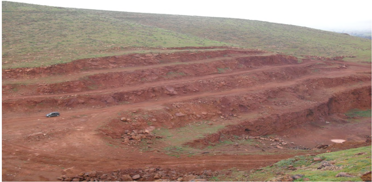
Figure IV.3 : Vue générale sur les gradins de la mine de Rouia.
