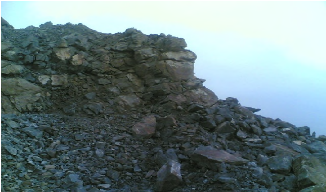
Figure II.1 : Terrains fissurées au niveau de ravin sud.
