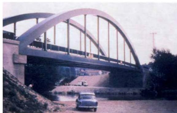
Figure I. 6 : Pont à poutres à âme pleine      Figure I. 7 : Pont à poutres Bow-strings
