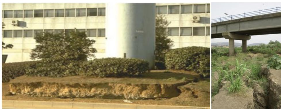
Figure III. 14: Exemple de tassement de sol sous fondation de pont (Kobé, 1995) et liquéfaction du sol au pont des Isser (Boumerdes, 2003)
