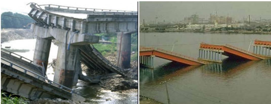
Figure III. 8: Photos de ponts totalement endommagés par le séisme de Taiwan en 1999 à gauche et Nigata, 1964 à droite.
