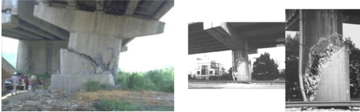
Figure III. 12: Exemple d'endommagement par cisaillement des piles
