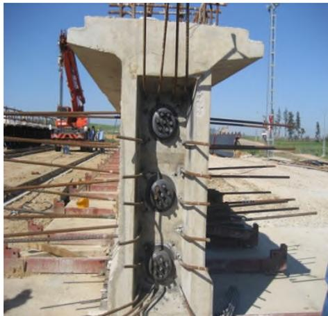
Figure I. 15 : Poutre en précontrainte
