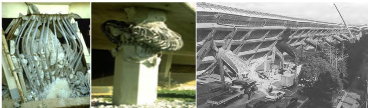
Figure III. 11: Exemple d'endommagement par insuffisance de ductilité flexionnelle (séisme de Kobé)
