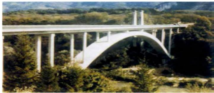
Figure I. 3 : Pont à tablier supérieur
