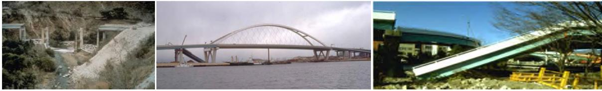
Figure III. 7: Photos de ponts ayant subis des dommages de type chute du tablier
