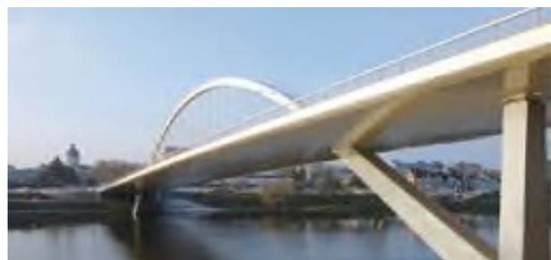
Figure I. 5 : Pont à tablier intermédiaire
