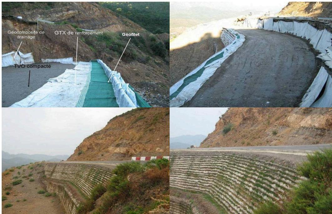
**Figure IV. 5:**renforcement des talus par nappe géotextiles
