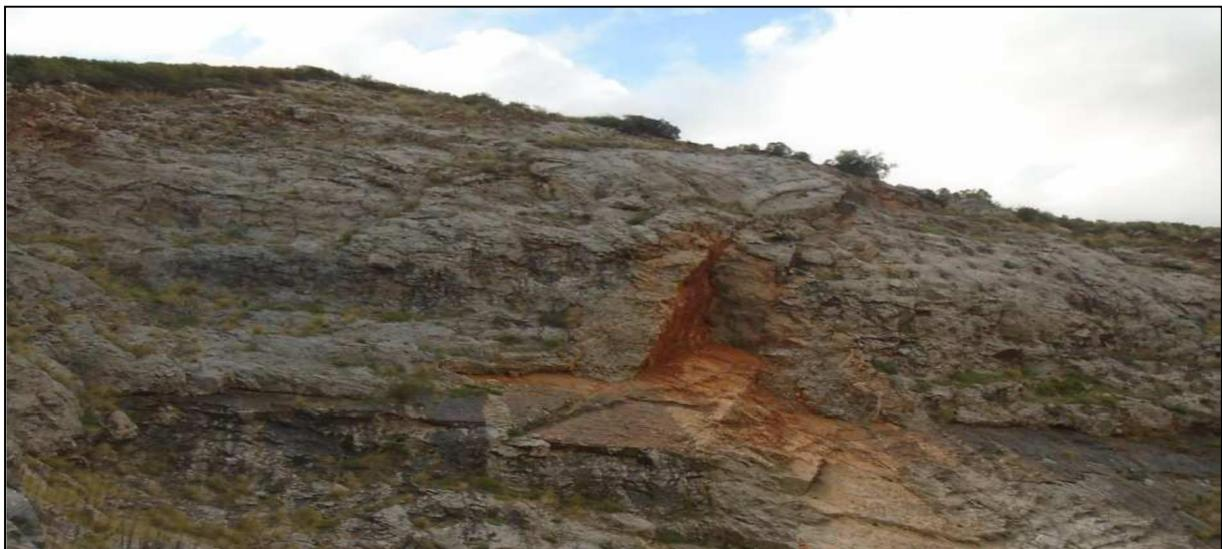
**Figure III.9.** Glissement en dièdre dans un massif (Aokas –Bejaia-, 2015). [3]
