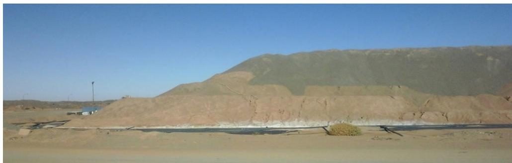
**Figure I.6:** tas de lixiviation du minerai aurifère de la mine d'Amesmassa
