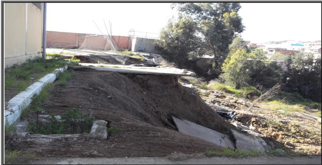
*Figure 43: vue profil de glissement de terrain affectant la salle de omnisport de Thenia*
