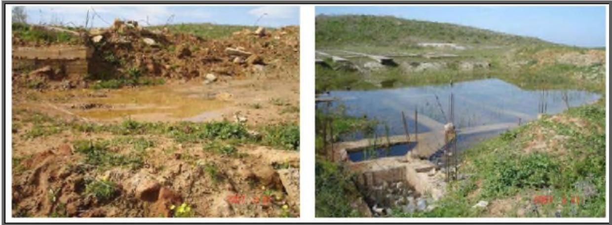
*Figure 16 : Stagnation des eaux en amont dans des fondations abandonnées.*
