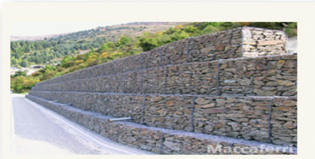
**Figure 30:** Mur de soutènement en gabion
