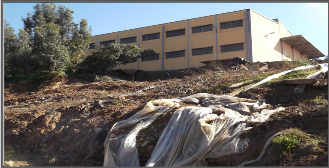
*Figure 42: vue de glissement de terrain affectant la salle de omnisport de Thenia*
