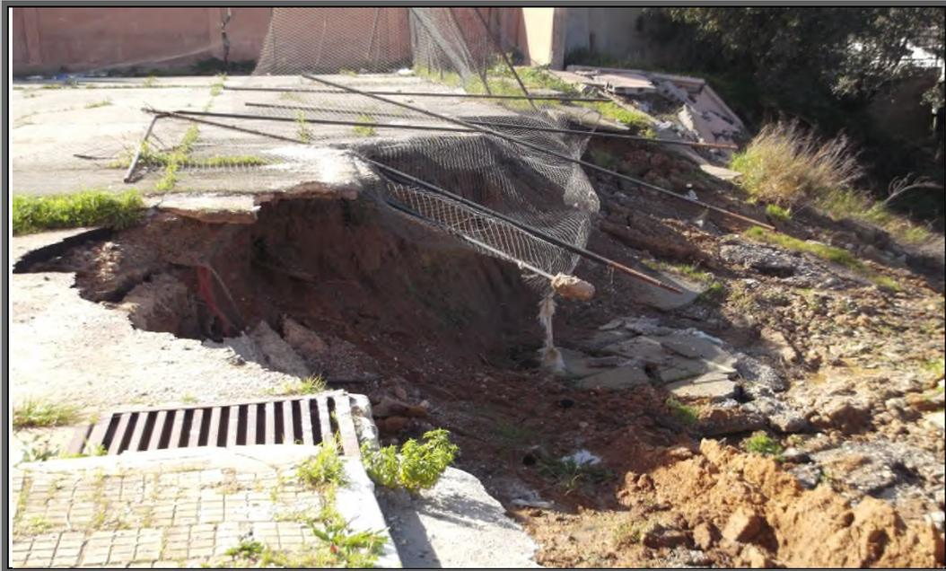
*Figure 41: Affaissement de la plate forme.*
