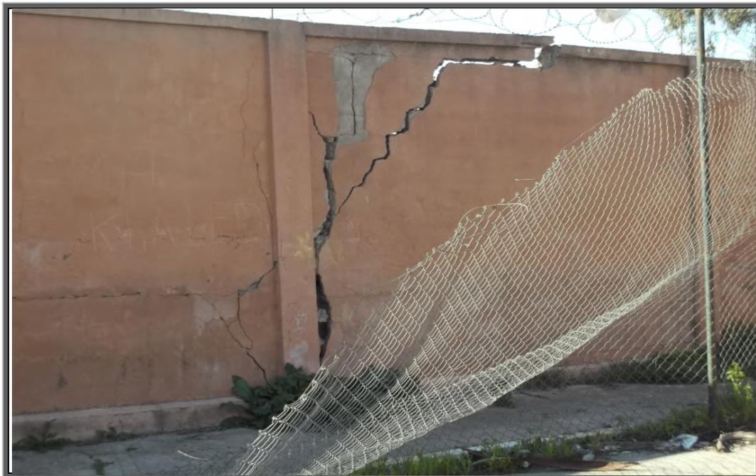
*Figure 40: fissures importantes du mur de clôture*
