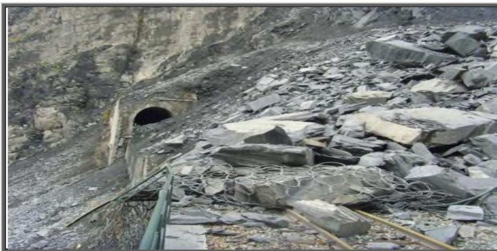
*Figure 8 : Eboulements, chutes de blocs et de pierres*
