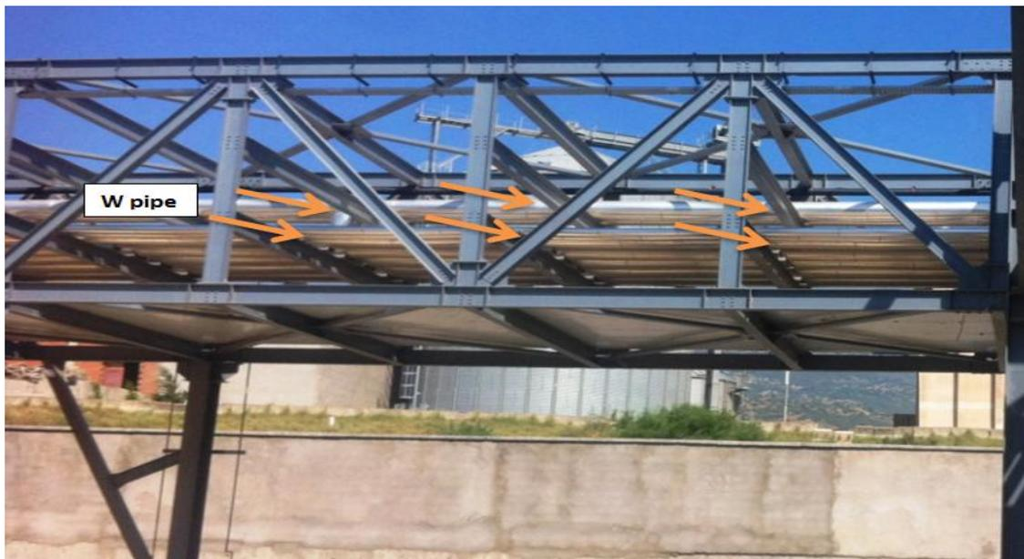
Figure 4.1 : Pression du vent sur les tuyauteries  $W_{\text{pipe}}$
