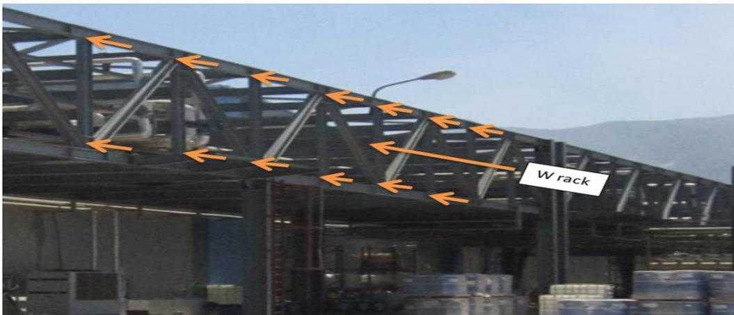
Figure 4.4 : Pression du vent sur le rack  $W_{\text{rack}}$
