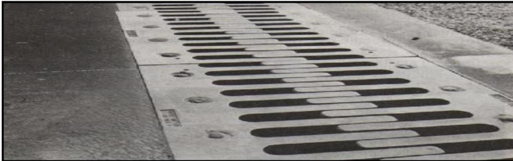
*Fig.IX.7 : Les joints de chaussée.*
