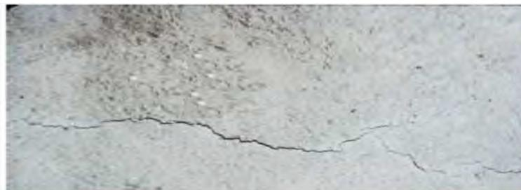
Figure 1.7. Fissuration due au retrait plastique ressemblant à une déchirure dans la surface de béton.
