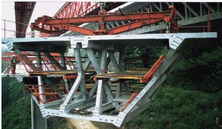
*Figure. I.5 Pont à caisson ou voussoir [2]*
