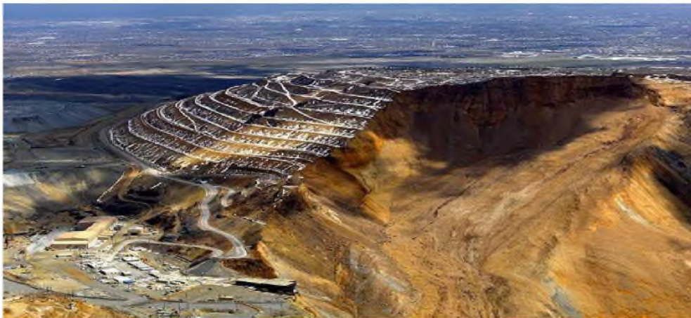
Figure II.1. Cas du glissement circulaire de la mine d'Utah en 2013 (U.S.A).
