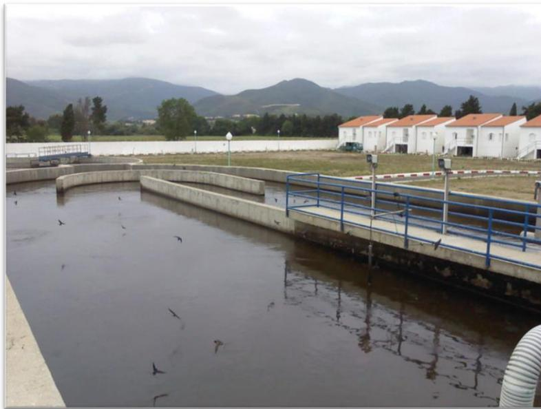
**Figure III-16: Réacteur biologique (système Carrousel)**
