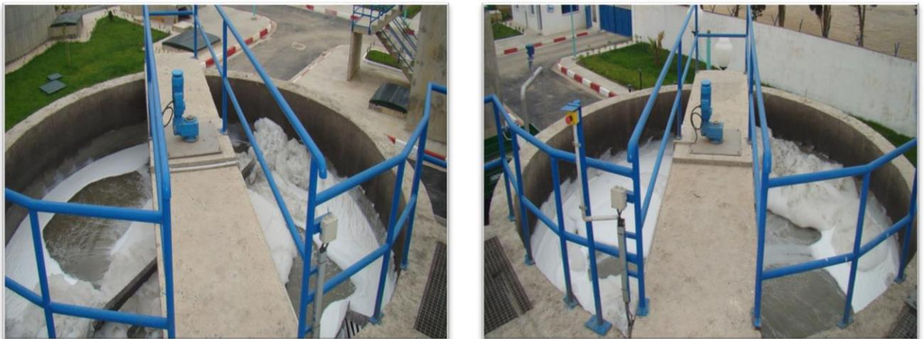
**Figure III-15 : Vue d'ensemble sur la séparation du sable et de la graisse.**
