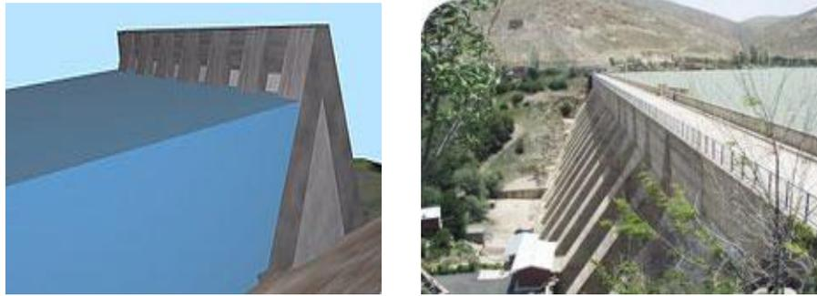
Figure 1.4. Barrage à contreforts d'Ekbatan (Iran)
