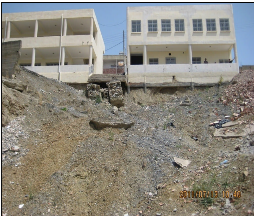
Figure I-7 : Photo montrant l'arrachement principal
