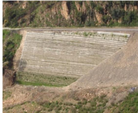
**Figure V.12 :** Ouvrage souple, en géotextile
