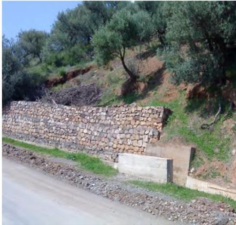
**Figure V.11 :** Ouvrage souple, en gabion
