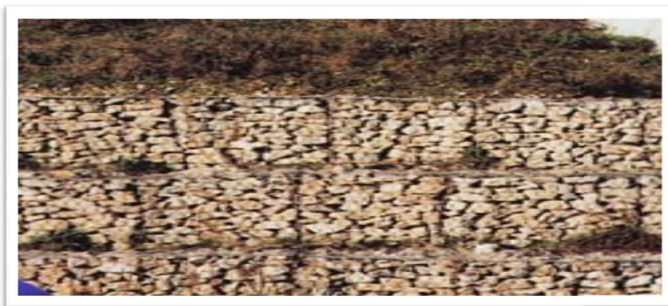
Figure V.9 : mur de soutènement en gabion [8]
