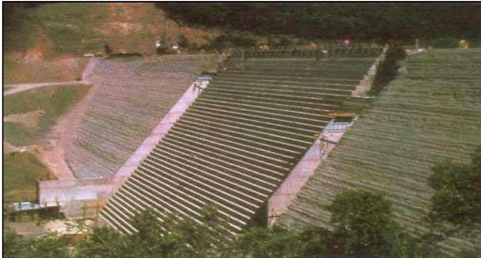
*Figure 3- Barrage poids en BCR des Olivettes (France H = 35 m) [4]*
