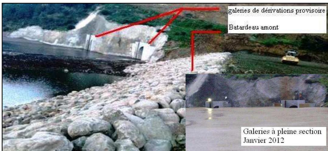
Figure 13- Ouvrages de dérivation provisoire (Barrage Tabellout Algérie en construction)
