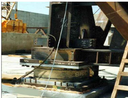
n. Isolateur à la base d'un poteau métallique
