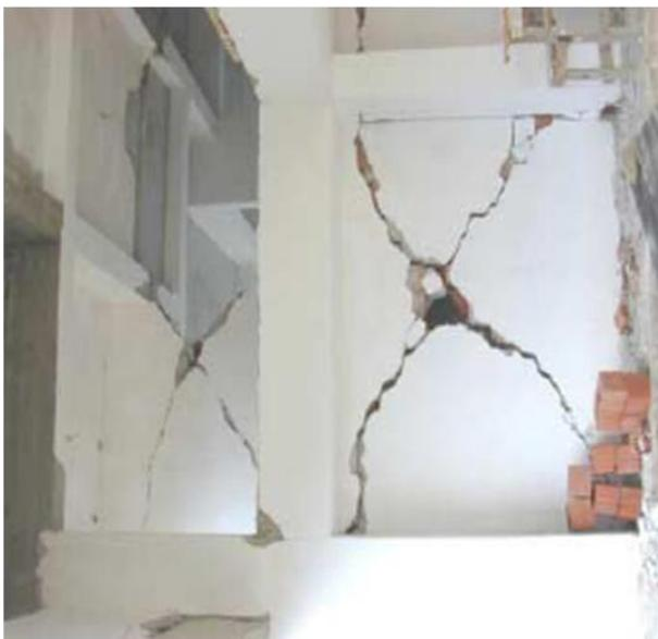
*Figure I.15 : Fissure en X de la maçonnerie*
