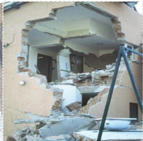
*Figure I.16 : Effondrement de la maçonnerie*
