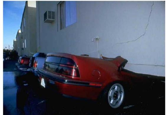
**Figure I.18 : Cisaillement de l'étage souple.**
