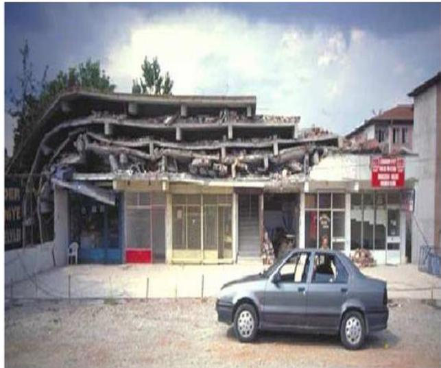
*Figure I.14 : Effondrement total du bâtiment*
