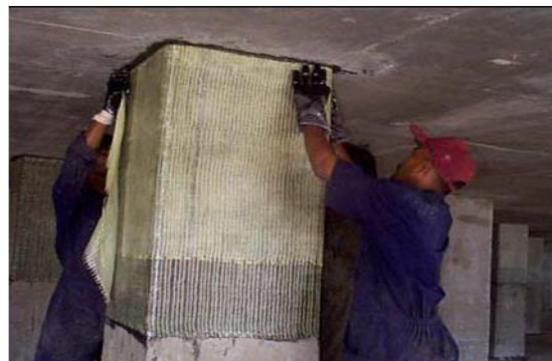
h. Renforcement d'un poteau avec des chemises en matériaux composites
