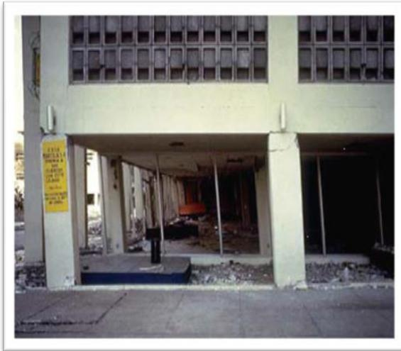
**Figure I.9.** Les poutres sont dimensionnées plus largement que les poteaux
