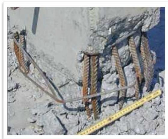
***Figure I.12 : Éclatement du béton et flambement des armatures à la base***
