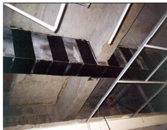
o. Renforcement d'une poutre avec des chemises en matériaux composites.
