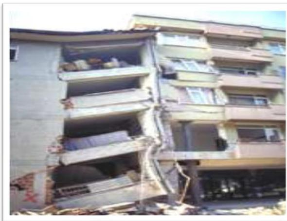
***Figure I.11 : Endommagement et rotation des poutres***
