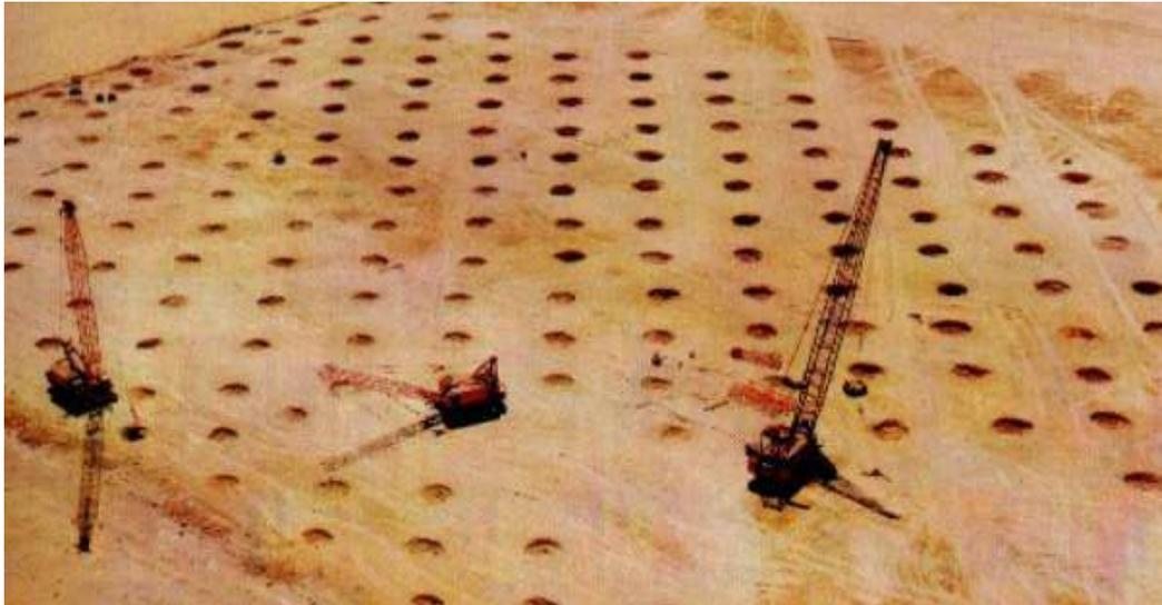
**Fig II.5.** Chantier de pilonnage
