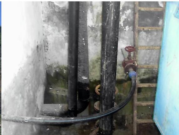
**Figure (III-7) :** Chambre de vanne de la station de reprise 01 (SR1).
