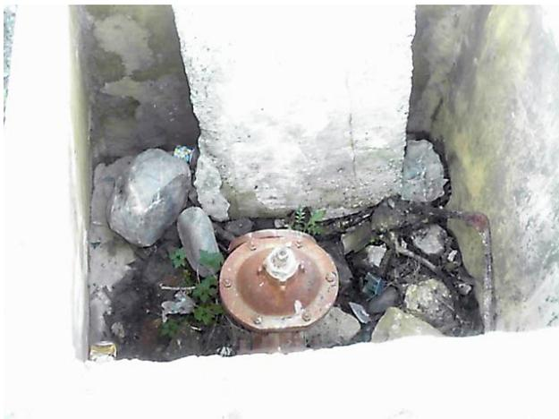
**Figure (III-14) :** Robinet de vidange installé sur la conduite de refoulement du forage.
