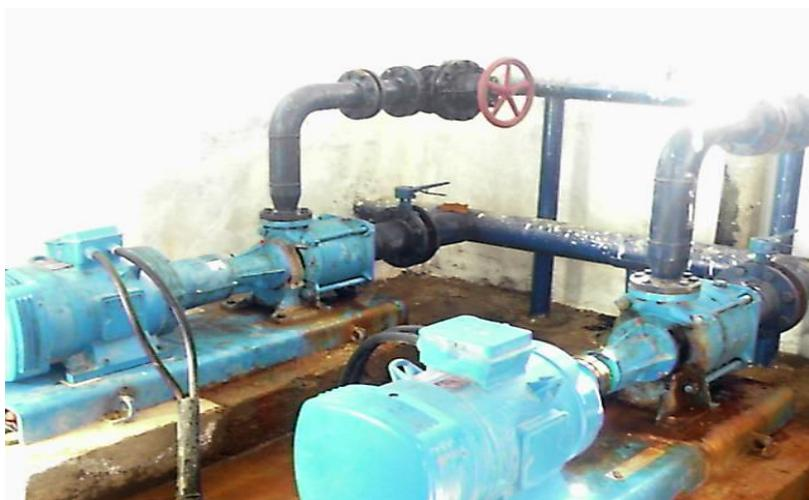
**Figure (III-10) : Dégradation des équipements de la station de reprise 02 (SR2)**
