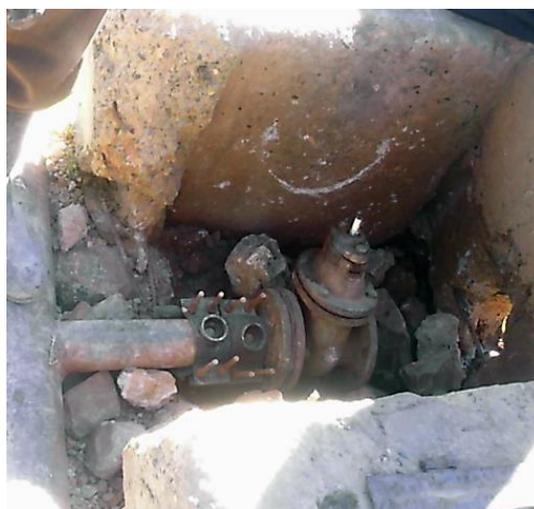
**Figure (III-12) :** Robinet de vidange de la conduite d'adduction d'EL MINA.
