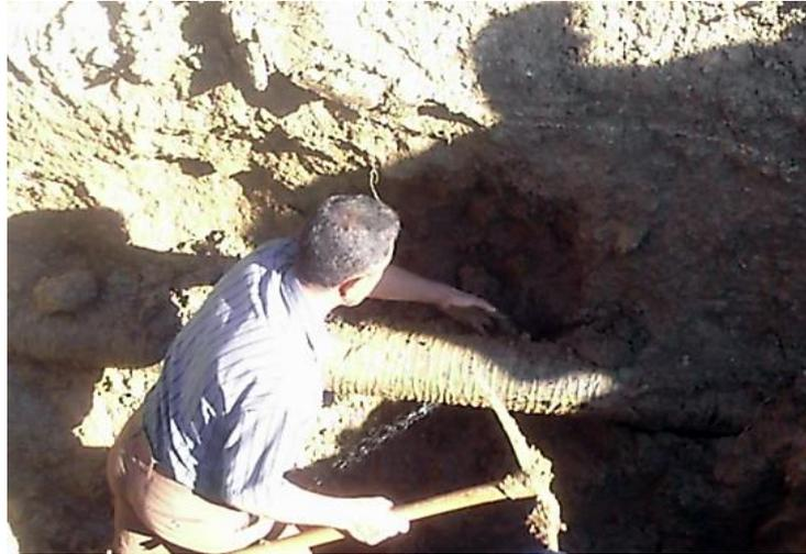
**Figure (III-13) :** Dégradation avancée de la conduite d'adduction entre les stations de reprise 01 et 02 (SR1 et SR2).
