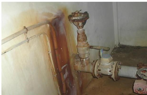
**Figure (II-3) : Purgeur et compteur installés sur le forage de l'oued DJEMAA.**
