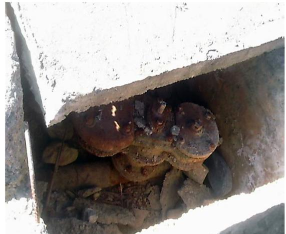
**Figure (III-15) :** Ventouse installée sur la conduite de refoulement du forage.
