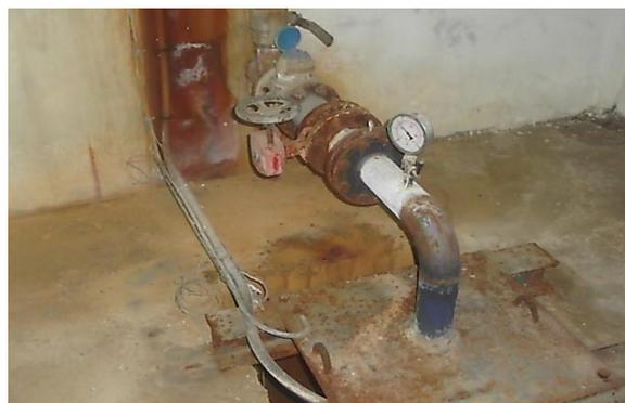
**Figure (III-4) : Corrosion de la tuyauterie du forage de l'Oued DJEMAA.**
