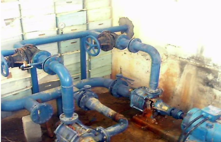
*Figure (III-8) : Dégradation des équipements de la station de reprise 01 (SR1).*
