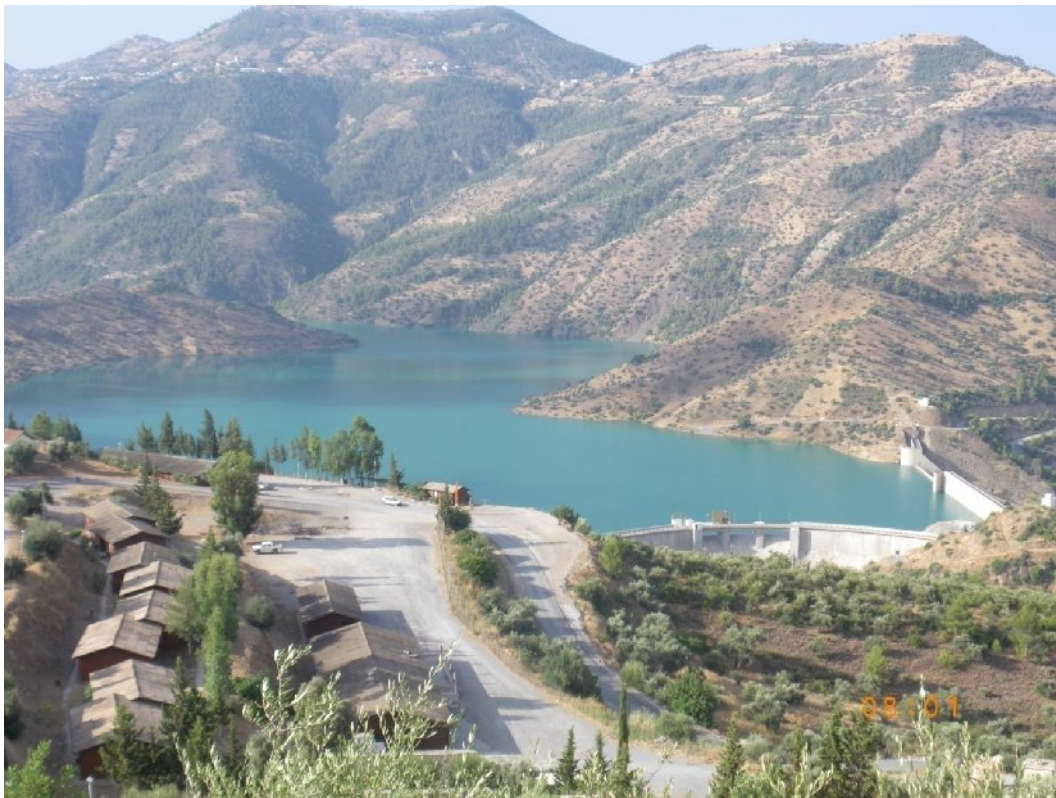
Figure 02 : Vue globale du barrage de Tichi Haf (collection personnelle).
