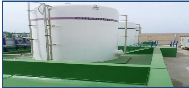
Figure IV.4 : Etape de prétraitement chimique
