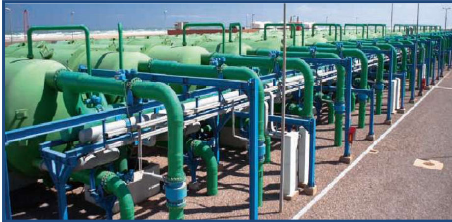
Figure IV.5 : Filtres à sable et anthracite
