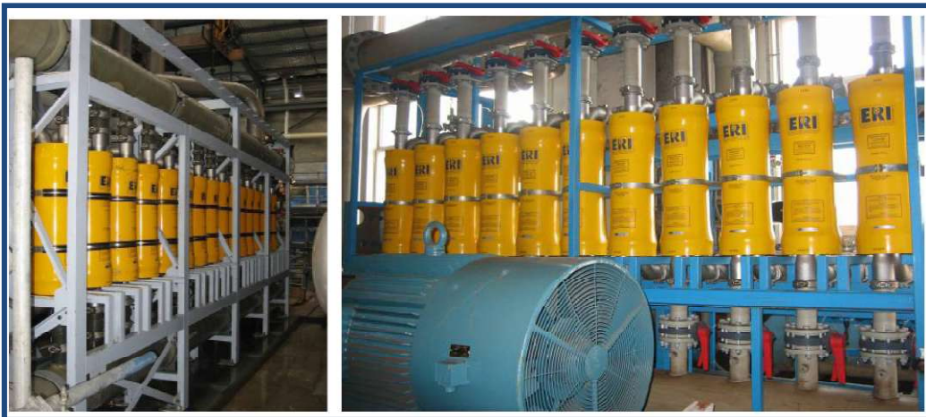
Figure IV.10 : Emplacement des échangeurs de pression
