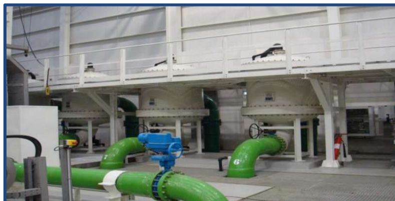
Figure IV.6 : Filtres à cartouches
