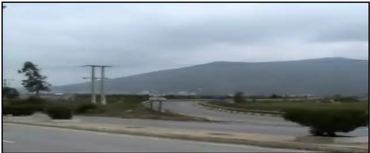
Photo III.1 : Photos de la RN 9 et l'échangeur Aboudaou qu'il faut traverser.
