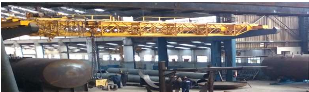
Figure I.2: Pont roulant dans un atelier.
