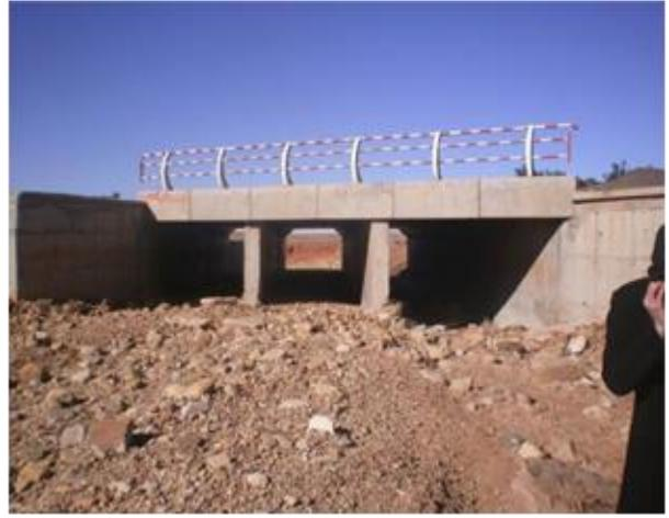
**Figure II.7 :** *Oued Saffiet en amont de l'Oued Deffa*      **Figure II.8 :** *Pont sur Oued Saffiet avec charriage*
