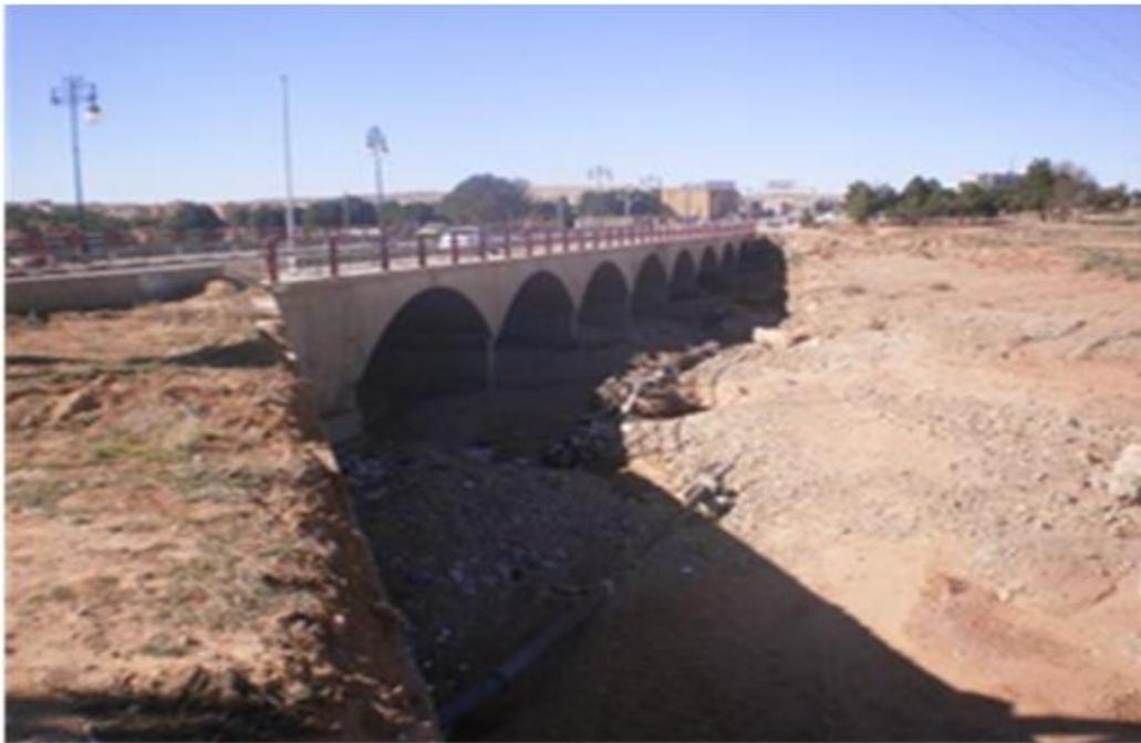
**Figure II.9 :** *Pont menant vers Tiaret entrée de la ville avec une conduite d'AEP*
