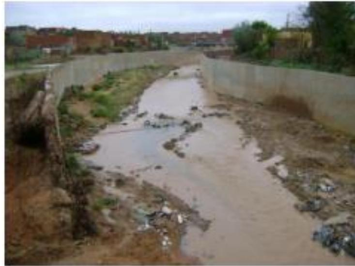
*Figure II.13 : Oued Deffa avec les voiles de protection en partie détruits*
