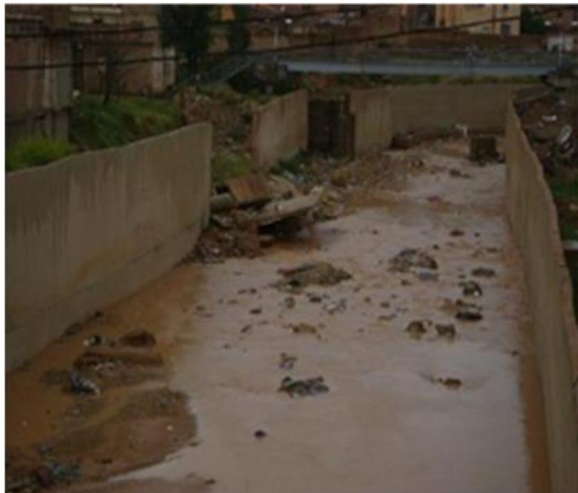
*Figure II.14 : Oued Deffa avec les voiles de protection en partie détruits*
