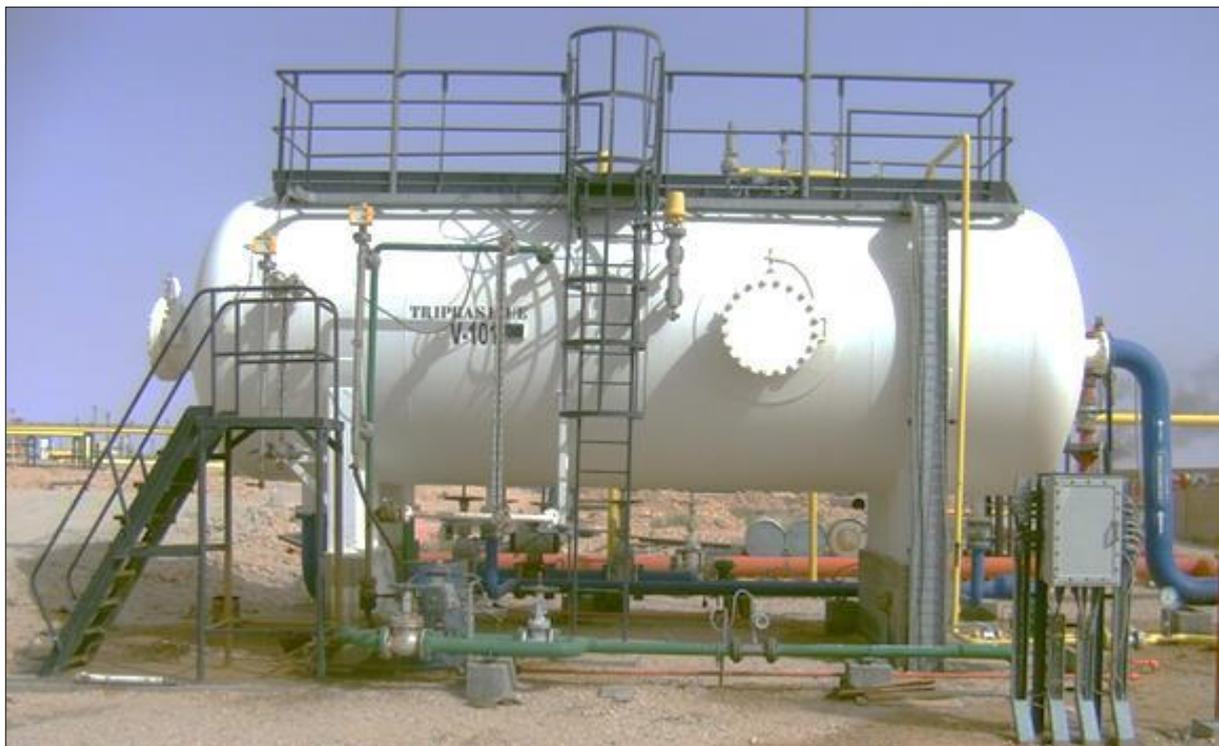
**Figure III.2:** Séparateur tri-phasique de l'unité de déshuilage du CIS
