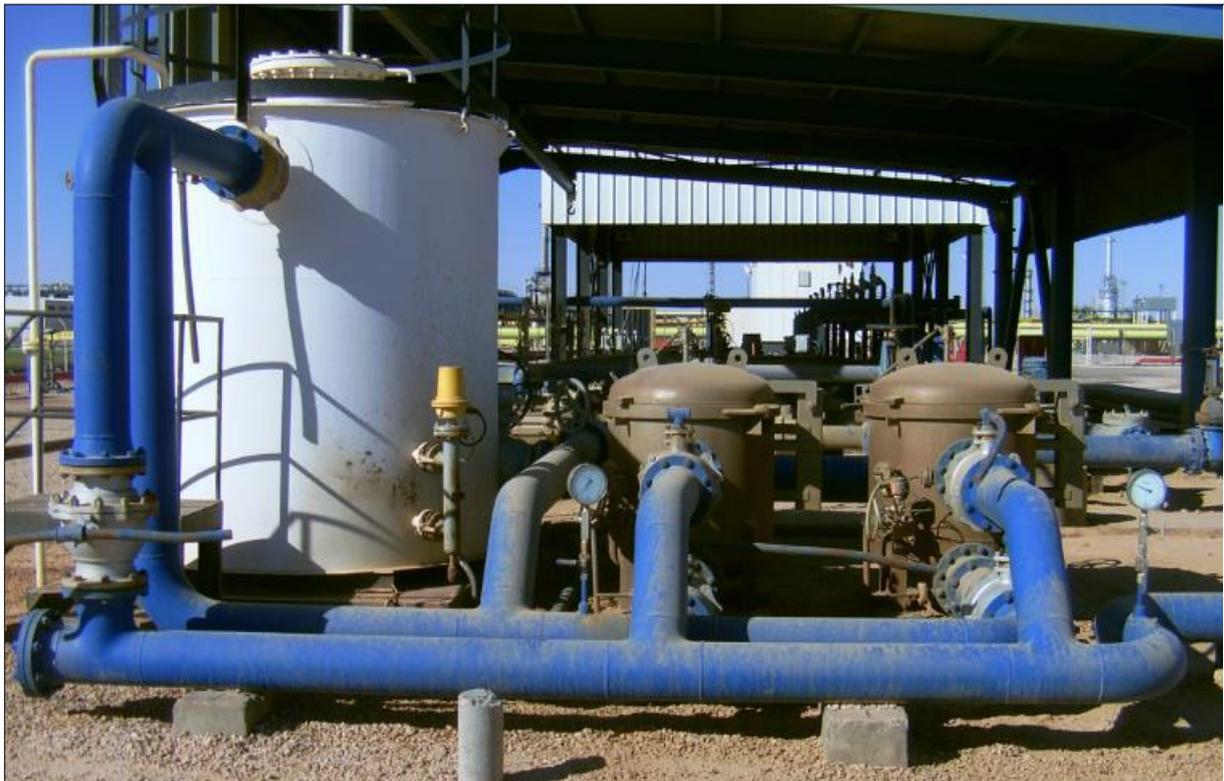
**Annexe A.1** : Filtres et réservoir de stockage d'eau traitée de la station de déshuilage du CIS
