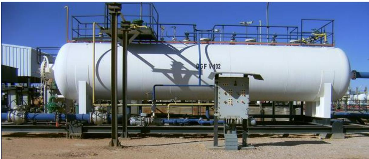
**Figure III.13:** Ballon DGF de l'unité de déshuilage du CIS
