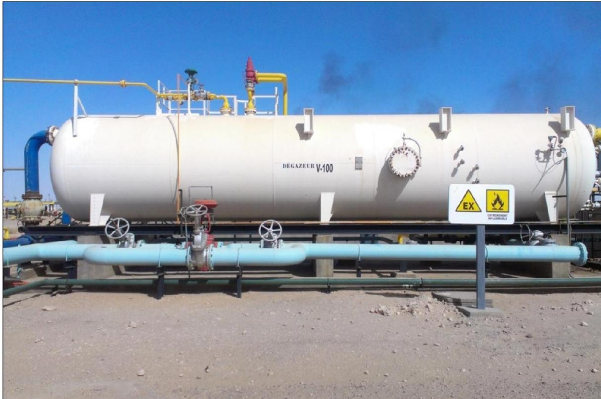
**Figure III.4 :** Dégageur de l'unité de déshuilage du CIS
