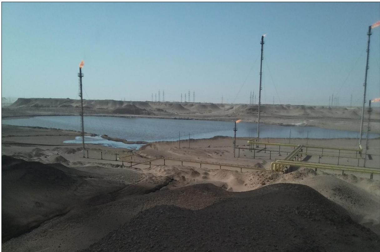
**Figure IV.3 :** Bourbier retenu par une géo-membrane (photo prise le 19/03/2016)
