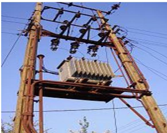
Figure-I.8 : transformateur de puissance HTA / BT
