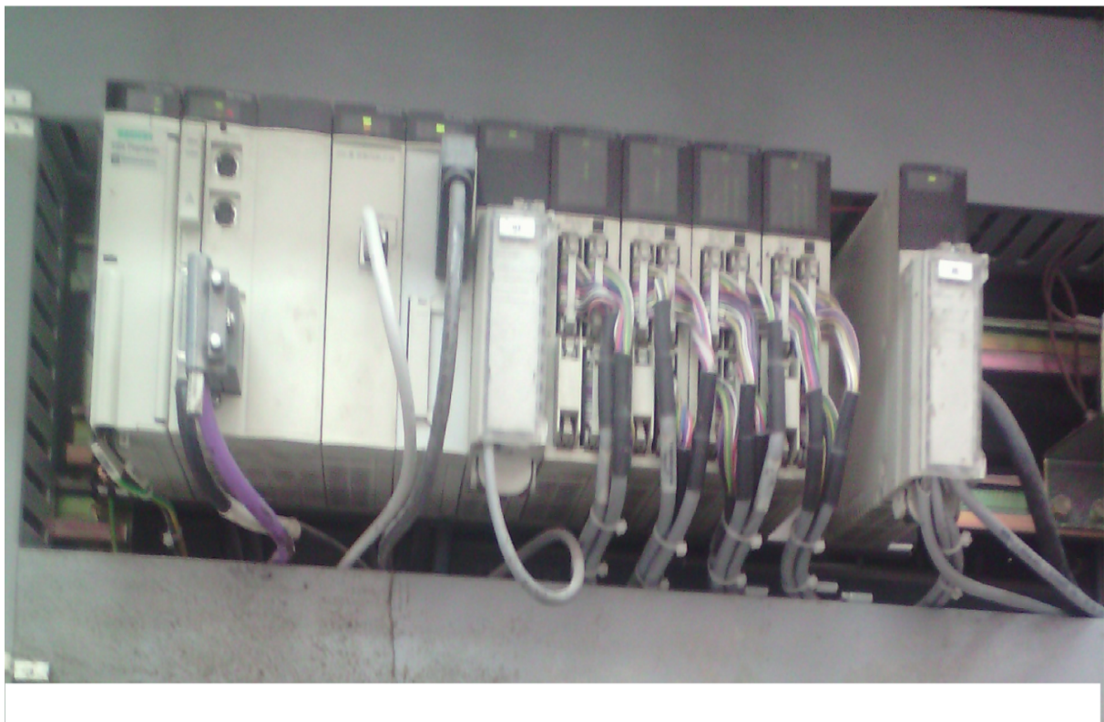
Figure II-16 : Structure générale de l'automate TSX 57353
