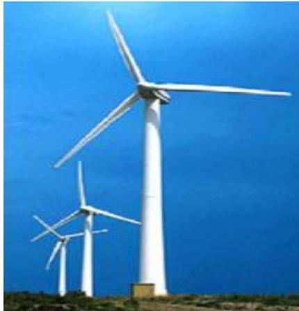
Figure [I.2] : Eolienne à axe horizontal
