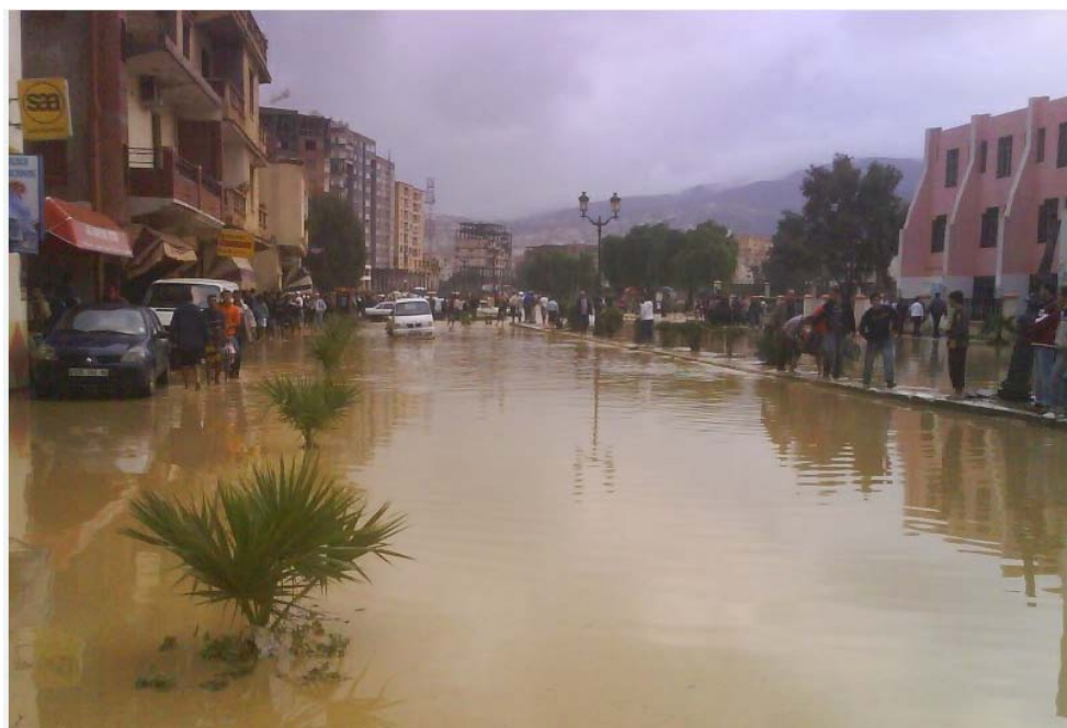
Figure : Stagnation des eaux pluviales à Amriw - Bejaia -
