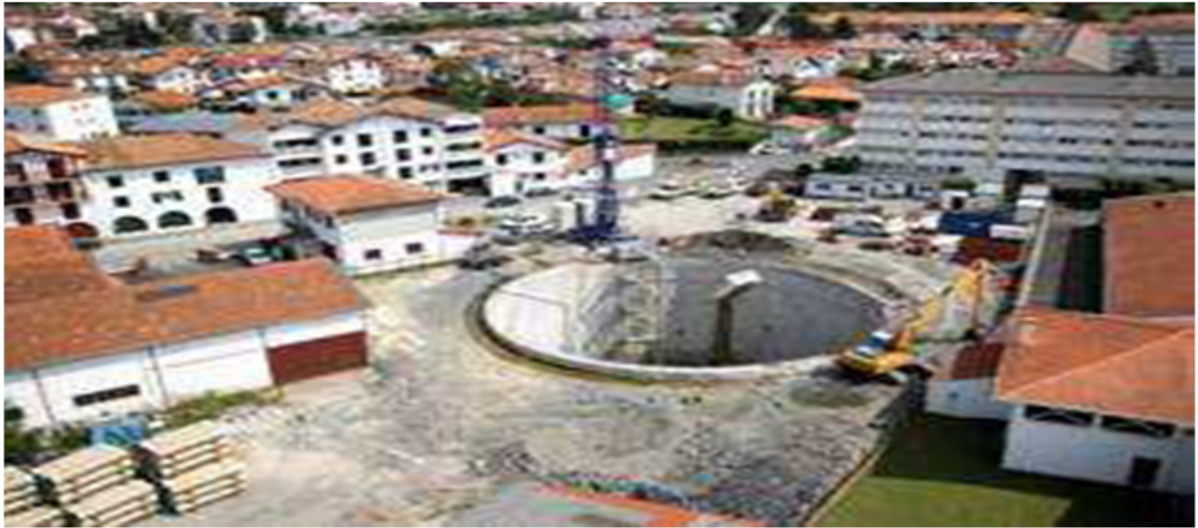
FIGURE 2.3 – Bassin de rétention, Ciboure - France-.
