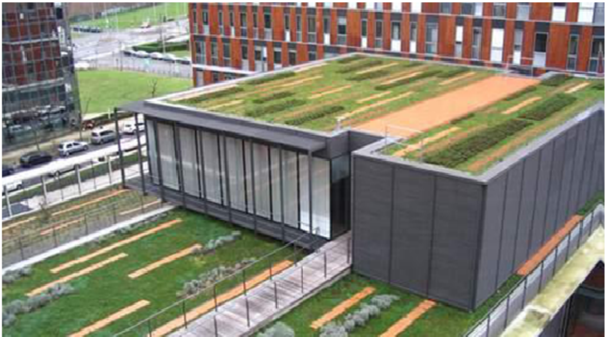
FIGURE 2.12 – Toits végétalisés à Noisy-le-Grand(France)
