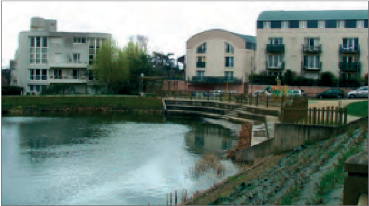
FIGURE 2.5 – Bassin de rétention à l'air libre, en ville -Ile de France-
