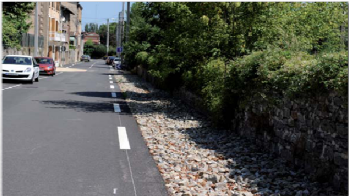
FIGURE 2.9 – Tranchée drainante (Vernaison - Impasse Port Rave- France.)
