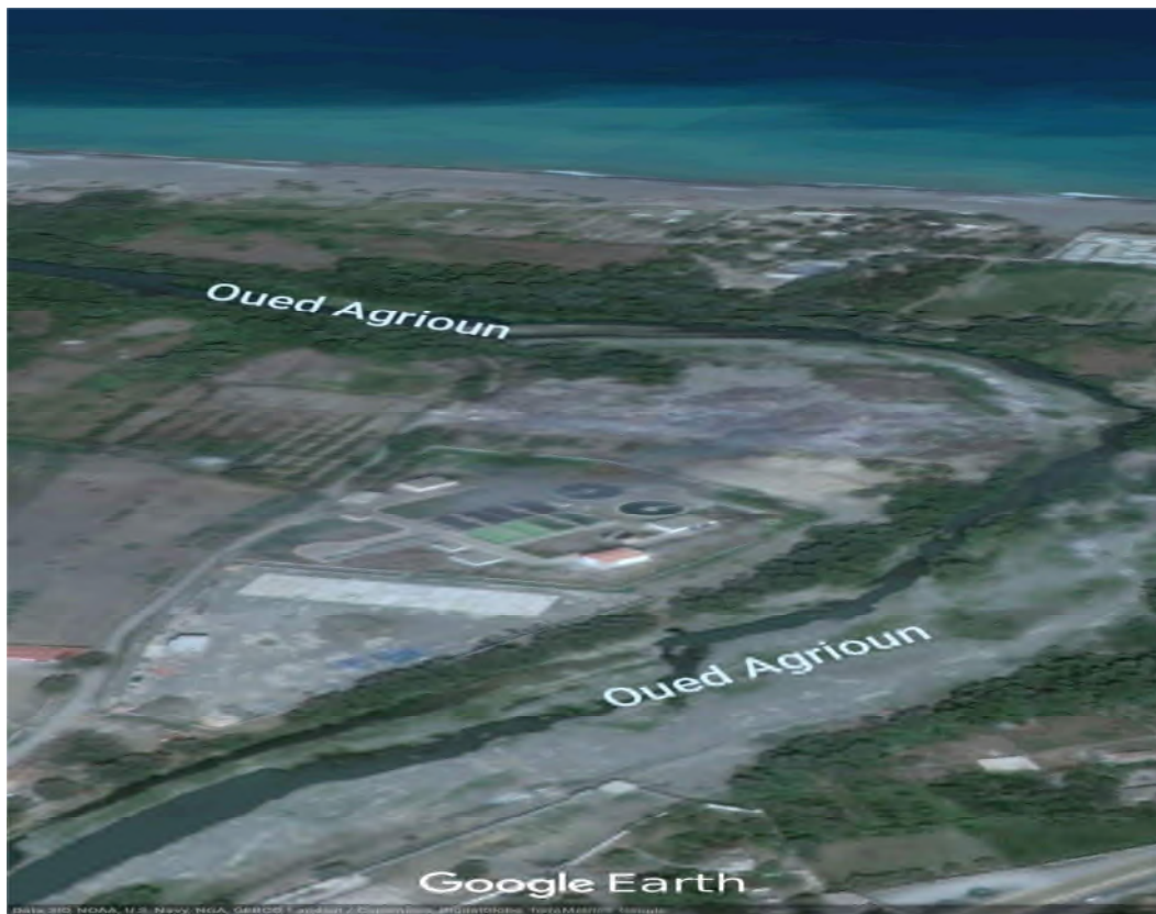
Figure 2.2: Vue de la station d'épuration de Souk-El-Tenine (Google Earth le 19.02.2018 à 10h44)
