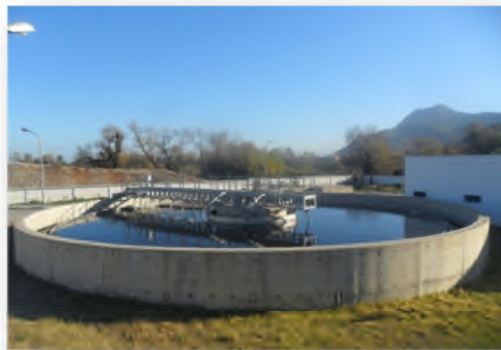
Figure 2.8: Décanteur secondaire (Cliché par Arouche & Touil, 2018).
